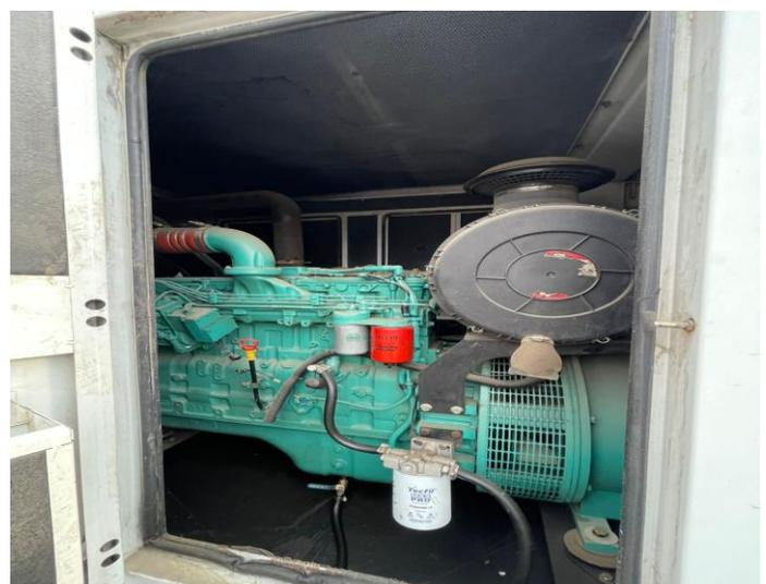
**DETALLE: 1 UN GENERADOR GENSYS MOTOR CUMMINGS 350KVA**
